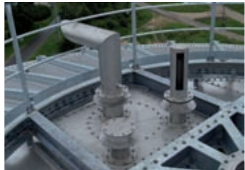
Über- und Unterdrucksicherung als Wassertasse Frostsicherer Einbau im Kronenring Funktionsprüfung im Werk
