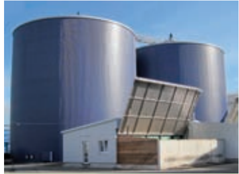
BGA Lünen 44532 Lünen Baujahr 2009 Volumen = 5.900 m 3
