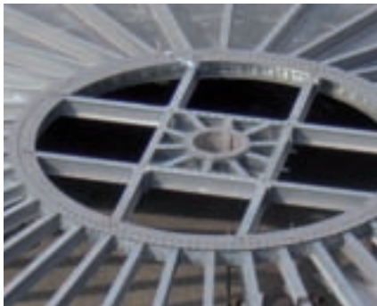
Dachkronenring Durchmesser von 2.300 bis 6.800 mm
