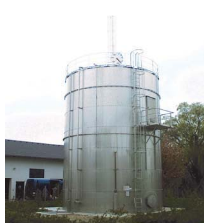
Bruchsal, Baujahr 2003 Niederdruckgasspeicher 45 mbar 350m 3 Besonderheit: Edelstahlausführung
