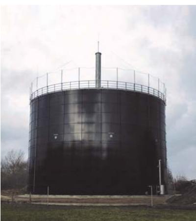
Bremen, Baujahr 2015 Niederdruckgasspeicher 50 mbar 5.000m 3 ; Besonderheit: Parallel- betrieb inkl. Vorschachtausrüstung
