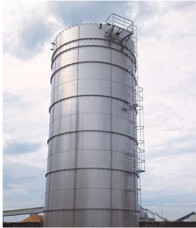
Baruth, Baujahr 2008 Heißwasserspeicher 669m 3 Ausrüstung: V4A-Dach, Isolierung Besonderheit: Medium bis 80°C
