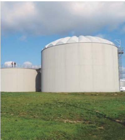
Altentreptow, Baujahr 2005 MAB 1.621m 3 / UASB 3.191m 3 Besonderheit: GFK-Abdeckung, bauseits VA-Flachdach
