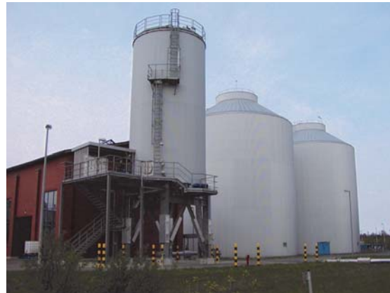
Kläranlage Wansdorf Dickschlamm-silo Typ 20 42,5 auf Traggestell 6 m über OK
