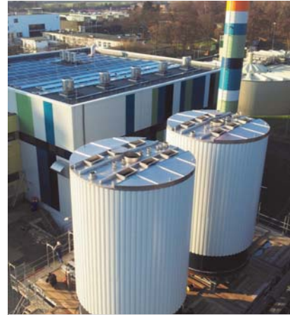
Köln, Baujahr 2013 Dickschlammspeicher 250m 3 Ausrüstung: V4A-Dach, Isolierung Besonderheit: Flachdach
