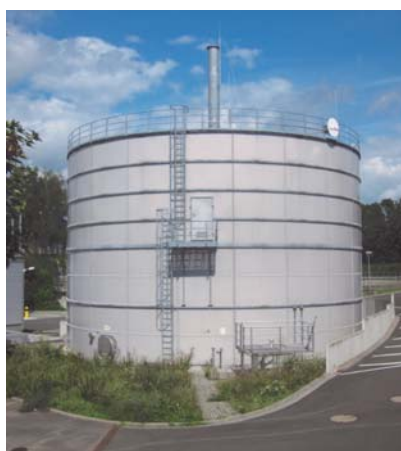
Wiesbaden, Baujahr 2006 Niederdruckgasspeicher 45 mbar 2.500m 3 Besonderheit: Sonderfarbe grau
