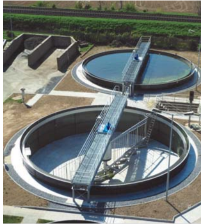
Wiesloch, Baujahr 2013 Eindicker 740m 3 Ausrüstung: Zentrale Brücke, Ablaufrinne, Krähwerk
