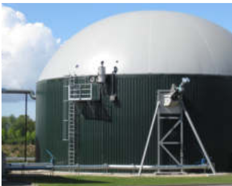
Hydraulische Über- und Unterdrucksicherung
