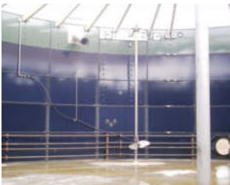
Tauchmotorrührwerk mit seitlicher, gasdichter Bedienungseinrichtung, seitliches Schneckeneintragsystem
