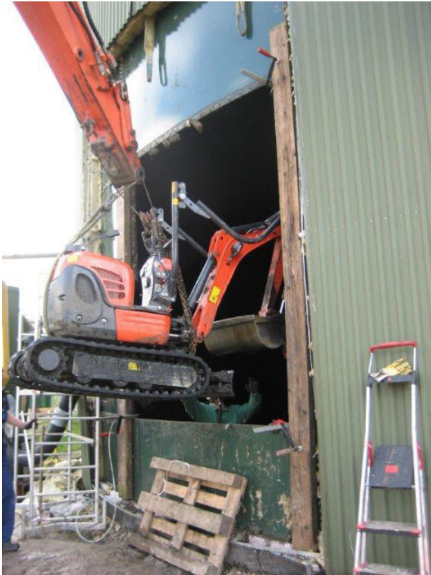
Demontage von zwei Behälterplatten Einhub eines Minibaggers / dismantling of two tank wall sheets for bringing mini-digger
