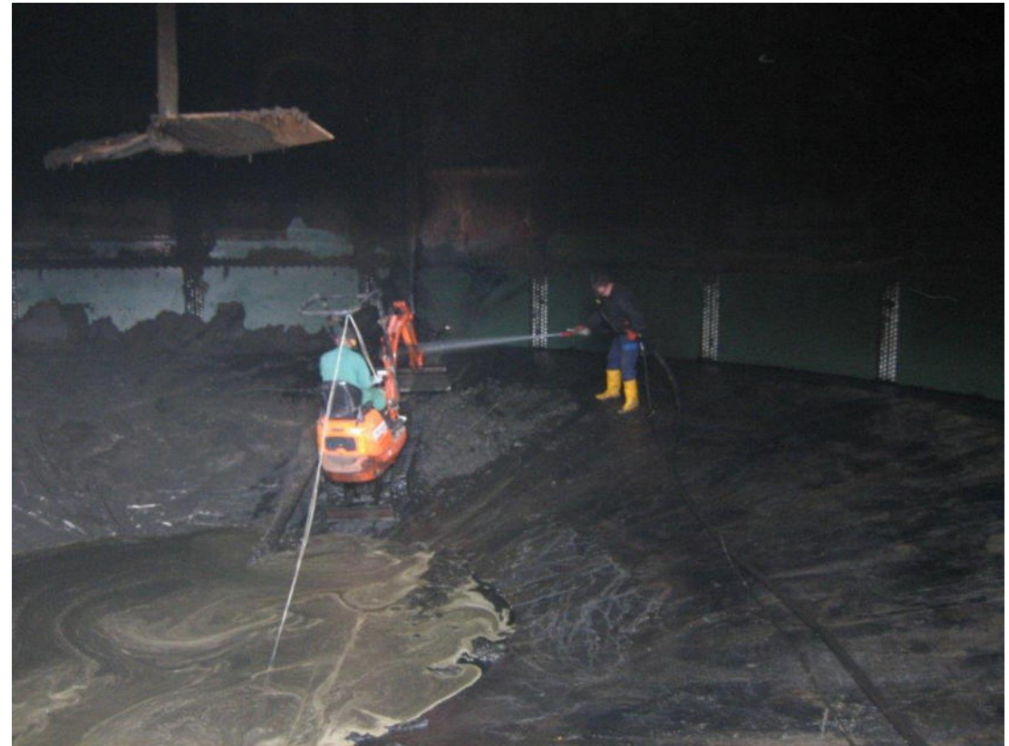
Abpumpen mittels Saugwagen bzw. über Pumpensumpf unter Zugabe von Wasser / Pumping out by suction truck or pump sump with water
