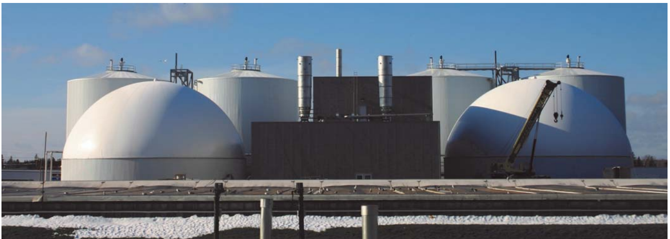
Biogasanlage in Kanada
