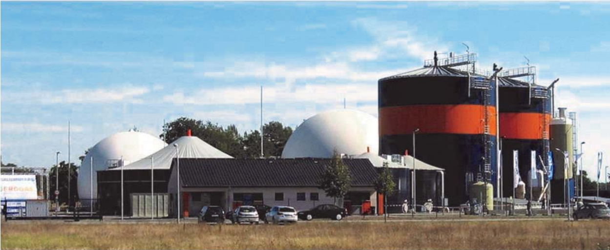
GreenGas Produktionsanlage in 14712 Rathenow 2 Fermenter à 5.000m 3 mit Zentralrührwerk, Kombispeicher 2.000 m 3 und 2.700 m 3 Gasspeicher, 3 Puffer- und Gärrestlager
