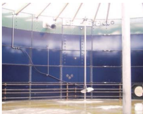
Tauchmotorrührwerk mit seitlicher, gasdichter Bedienungseinrichtung, seitliches Schneckeneintragsystem
