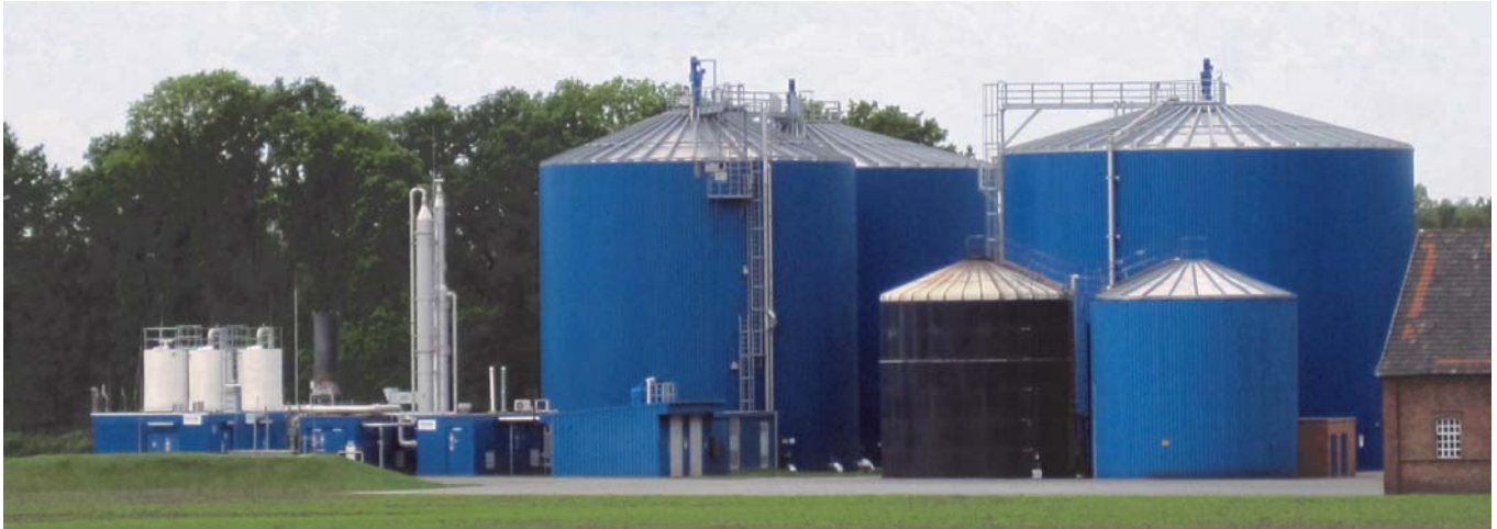
Biogas seit fast 40 Jahren: Biogasanlage Wenning, 46414 Rhede
