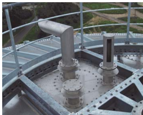
Über- und Unterdrucksicherung als Wassertasse Frostsicherer Einbau im Kronenring Funktionsprüfung im Werk
