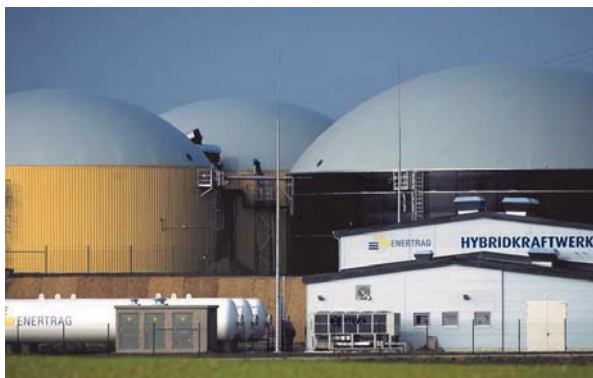
Hybridkraftwerk der ENERTRAG AG in Wittenhof
