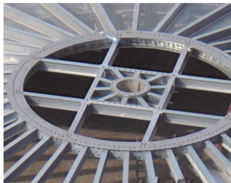
Dachkronenring Durchmesser von 2.300 bis 6.800 mm
