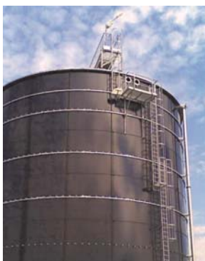
Fermenterbegehung über eine Aufstiegsleiter Wartungsbühne an den Schaugläsern
