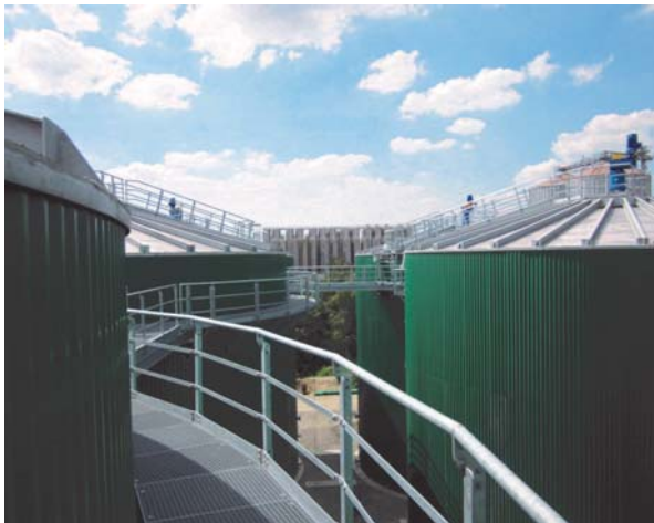
Biogasanlage Dorsten 46282 Dorsten Baujahr 2010 8 Fermenter mit jeweils 3.200m 3
