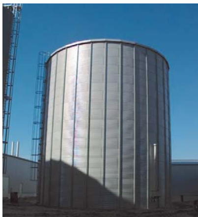
Kläranlage Friedrichshagen Druckloser Speicher Volumen: 2.500 m 3
