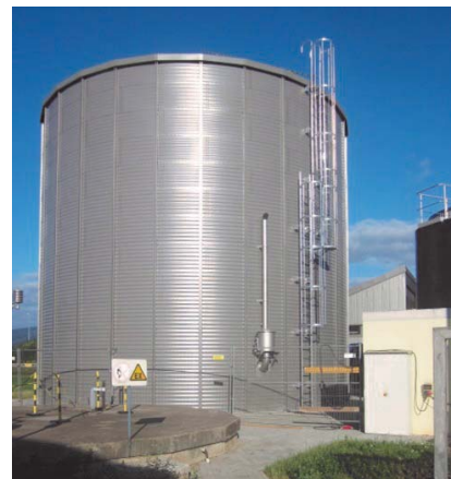
Biogasanlage Edenkoben Druckloser Speicher Volumen: 1.200 m 3
