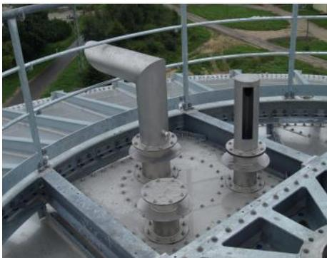
Über- und Unterdrucksicherung als Wasser-
