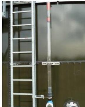
Kontinuierliche Füllstandsmessung des Gasspeichers
