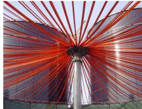
Edelstahlmittelstütze und Gurtunterkonstruktion
