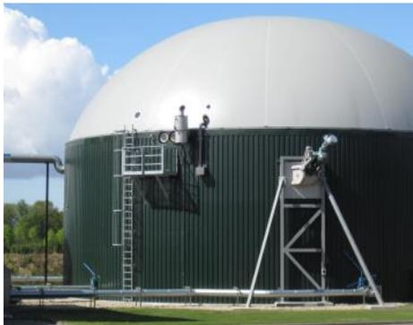
Hydraulische Über- und Unterdrucksicherung
