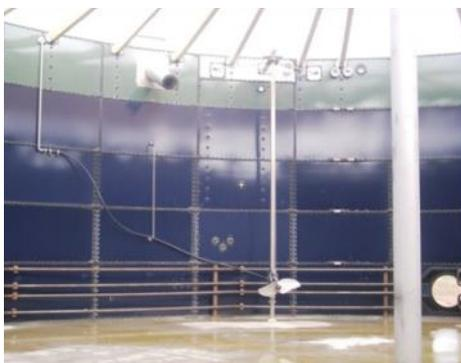
Tauchmotorrührwerk mit seitlicher, gasdichter Bedienungseinrichtung, seitliches Schneckeneintragsystem
